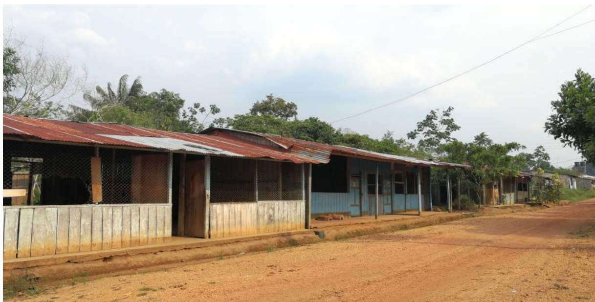
Ilustración 1 Condiciones De Viviendas Actuales De Los Campesinos Ubicados En La Región De Los Llanos Orientales
